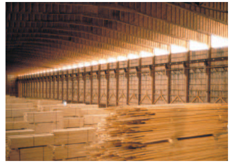
Prof em Hilding Brosenius utvecklade på 1940-talet HB-balken för militära ändamål, bland annat för reservbroar till malmbanan. Balkarna och sedermera även ramarna skulle kunna tillverkas av lokalt trämaterial av okänd kvalitet och av okvalificerad arbetskraft. Denna industribyggnad i Landsbro uppfördes 1947 och var en gång Europas största träbyggnad med frispännande takkonstruktion, volymen 300 000 m 3 . Bottenytan är 165x38 meter och fria höjden invändigt är 21 meter. (Foto: Carl Michael Johannesson)
