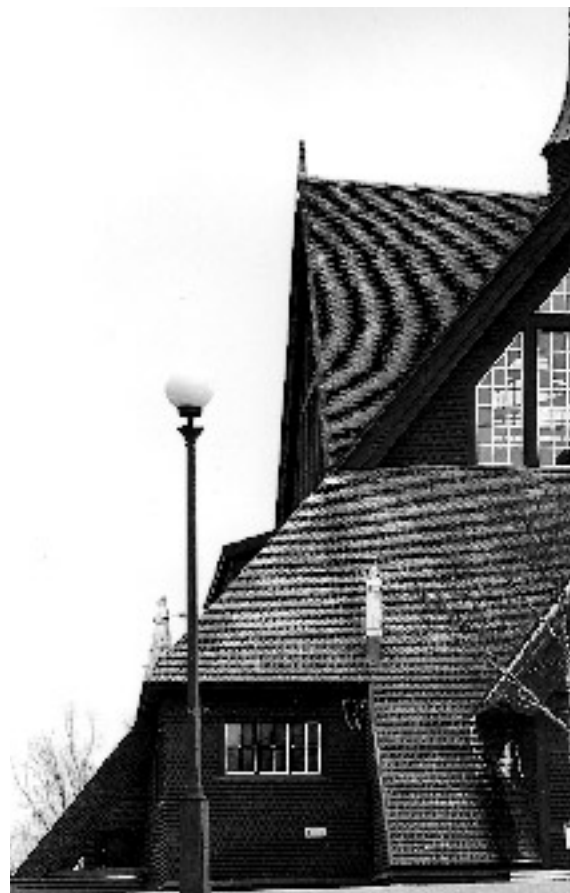
Kiruna kyrka uppfördes 1909–12. Den har beskrivits på följande sätt: "I såväl plan som sektion är kyrkan byggd på geometriska figurer. Planformen är en kvadrat och sektionen en likbent triangel. Volymen kan enkelt beskrivas som två varandra skärande prismor." Kyrkans
