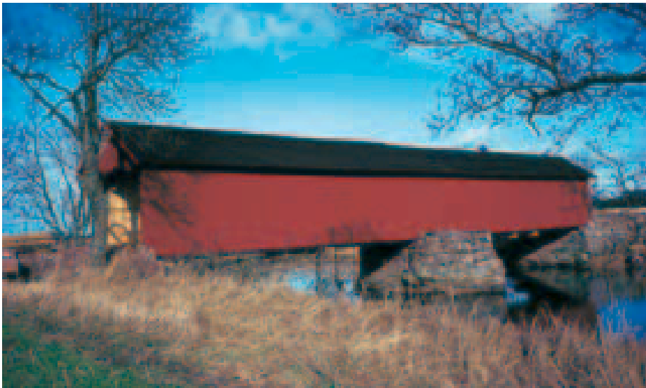
Vaholmsbron över Tidan är cirka 150 år gammal och ett svenskt exempel på en hus- eller ladbro. Den är 34 meter lång i två fack. Konstruktionen är ett dubbelt hängverk med överbyggnadens vägghöjd som konstruktionshöjd. (Foto: Träinformation)
