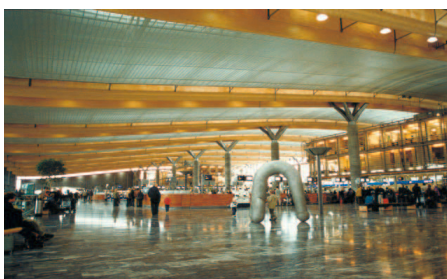
När normmännen skulle bygga ny flygplats valde man att använda trä i stora och viktiga konstruktioner som till exempel takbärningen med balkar som är 139 meter långa. Gardermoen flygplatsterminal invigdes den 1 oktober 1998. (Foto: Per Bergkvist)
