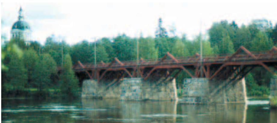
Lejonstömsbron i Skellefteå är en spännverksbro, förstärkt med hängverk i en del av spannet. Bron byggdes ursprungligen 1737 och är i sitt nuvarande utseende 207 meter lång. Den är upplåten för lättare allmän personbilstrafik. (Foto: Martin Gustavsson)
