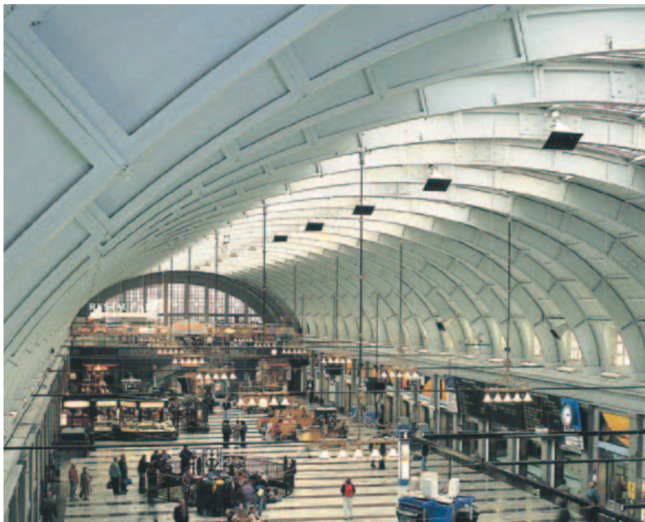
Hallen i Stockholms Centralstation är en milstolpe för svenskt limträ. Den uppfördes 1925 och har 24 meters spännvidd. Centralstationen var en av de första konstruktionerna som levererades från limträfabriken i Töreboda. (Foto: Töreboda Limträ)
