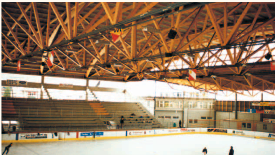
Väderskydd över en isbana i Thun, Schweiz. Tak av bågpackverk i limträ och dragstänger av stål.
