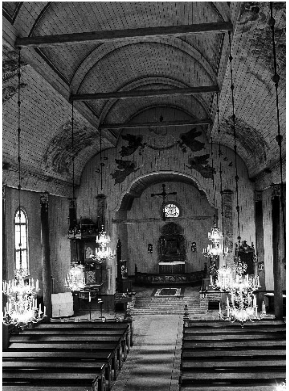
Dalby kyrka i Värmland uppfördes 1926–28. Tornspiran når 60 meter över marken. I kyrkorummet syns det för träbyggande unika treklövervalvet.
