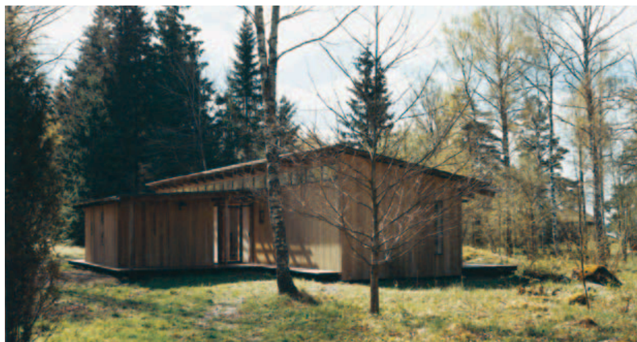
Husets entrésida med gästrum och förråd i en separat byggnad till vänster.
