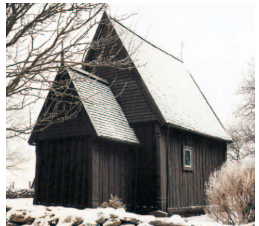
Hedareds kyrka är den enda bevarade stavkyrkan i Sverige. Den är medeltida och uppfördes omkring år 1500. Byggnadssättet är influerat främst från väster. Under Norges storhetstid på 1300-talet lär det ha byggts cirka 750 stavkyrkor. Byggnadssättet upphörde i början av 1500-talet, även i Norge. (Foto: Max Plunger)
