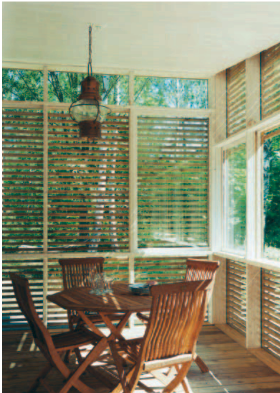
Inglasat uterum med öppningsbara fönster, myggnät och fällbara solavskärmare.
