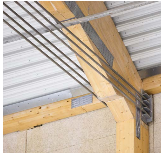
Infästningsdetalj i en bandyhall med limträstomme, Nässjö.
