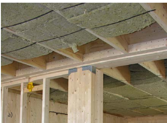
Figur 3.1 Exempel på böjbelastade element. a) Golvreglar, b) utvändig träkonstruktion.
