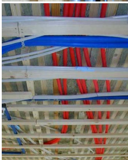
Figur 8.30 a) Ventilationskanaler förlagda till ett särskilt schakt. b) Installationer placerade under ett bjälklageelement före avslutande arbete.
