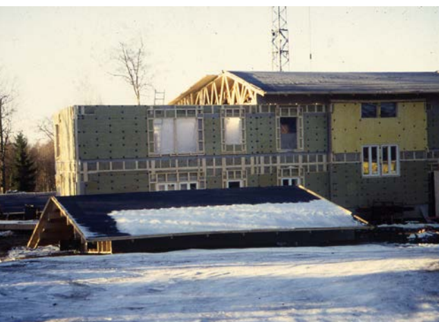
Figur 8.13 Tak utnyttjat som fuktskydd under resning av stommen.
