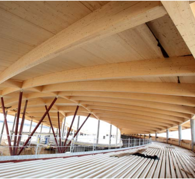
Takbjälklag av limträ och KL-trä.
