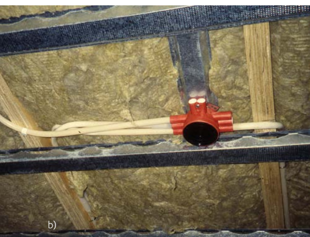
Figur 8.19 a) Typisk bjälklagsutformning i träbaserade stomsystem. b) Foto av undersidan av ett bjälklag med elinstallationer.
