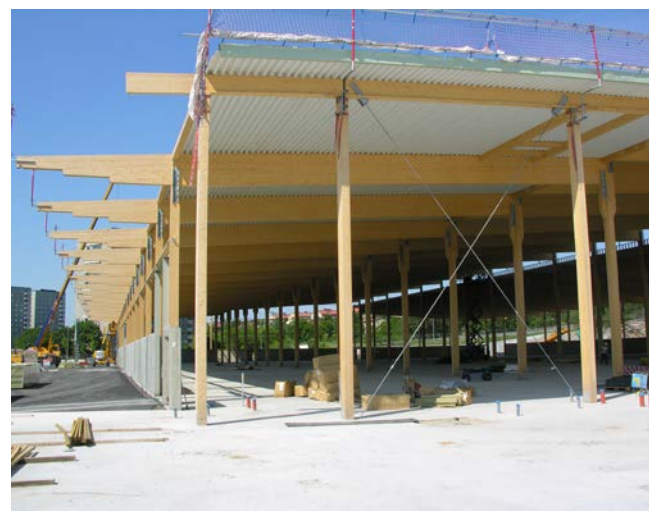
Limträhall under uppförande. Permanent vindkryss i ena gaveln för ner horisontella laster från styv takskiva av trapetsprofilerad plåt till grunden.
