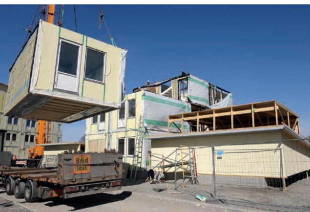
Figur 8.7 Montage av volymelement.
