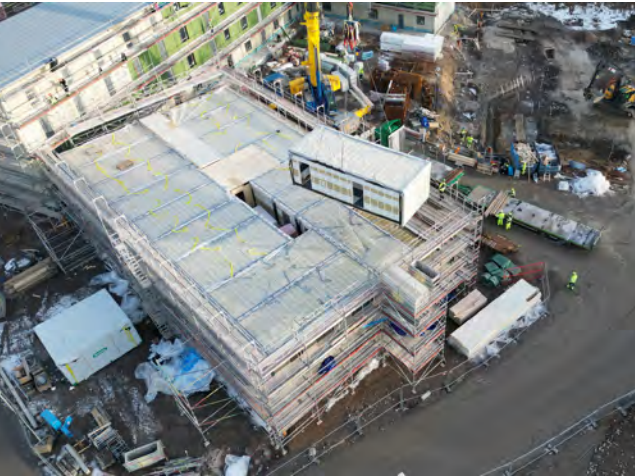
Montage av volymelement.
