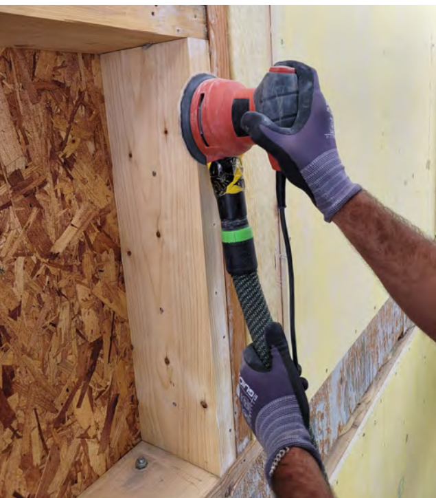
Sanering med hjälp av slipning.
