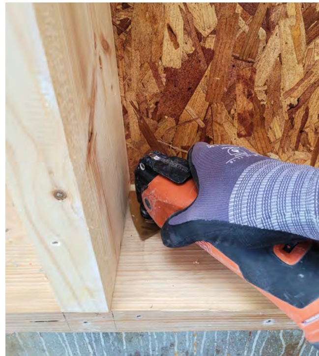
Användning av multiverktyg för åtkomst i hörn.
