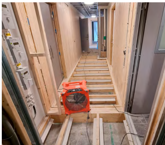
Pågående uttorkning av frilagt bjälklag.
