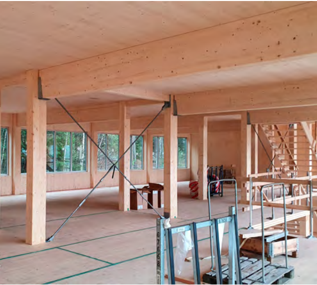
Kontorsbyggnad med stomme av limträ och KL-trä.
