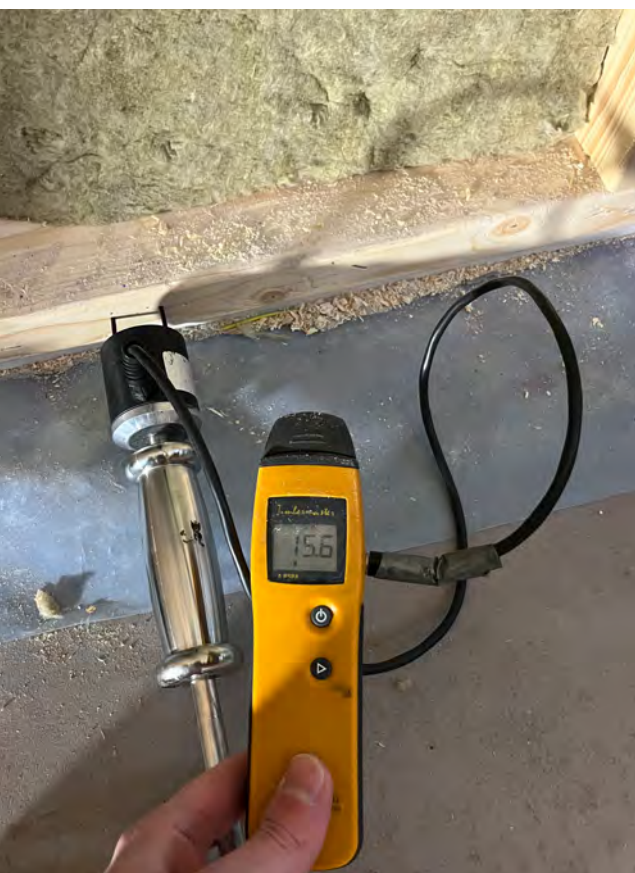
Mätning av fuktkvot.
