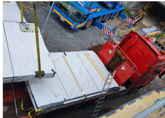
Mottagning av KL-träelement.
