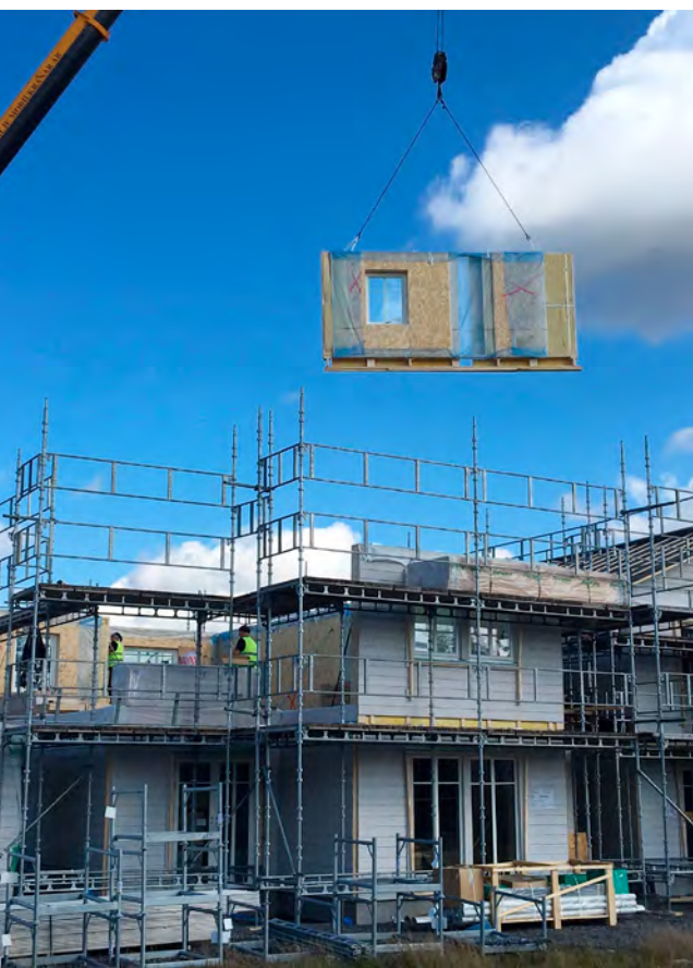
Montage av panelement
