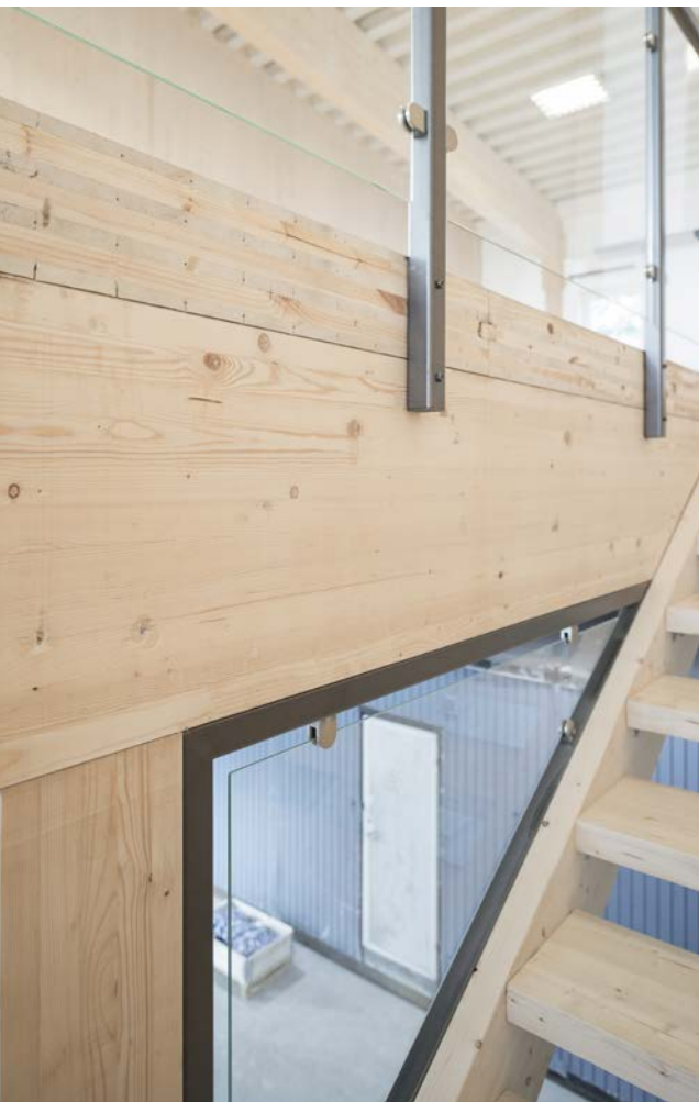
KL-träbjälklag i industrihotell, Älta.
