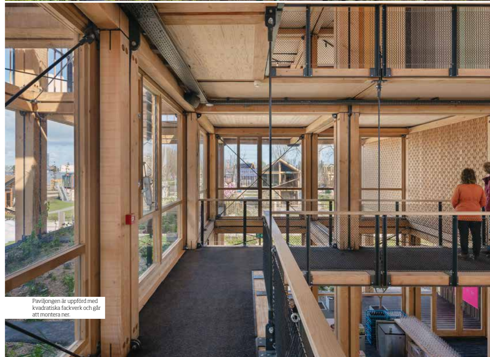
Lamellerna är placerade i olika mönster och styr inläppet av dagsljus och solvärme.
