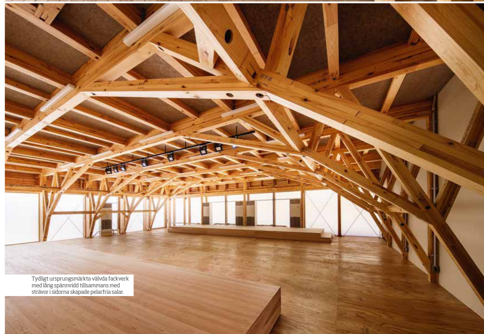
Den självbärande takkonstruktionen vilar på vridna pelare, specialdesignade för att stå emot jordbävningar.
