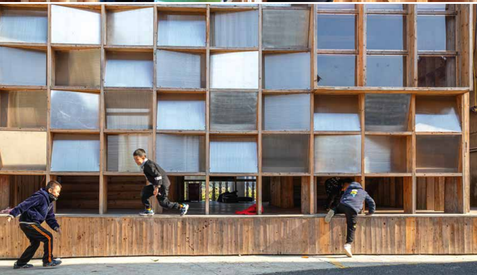
Skivor av polykarbonat har infogats i fasadens rutnät och lutats i olika vinklar för att leka med ljuset.
