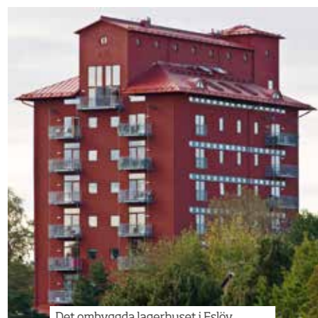
Det ombyggda lagerhuset i Eslöv.
