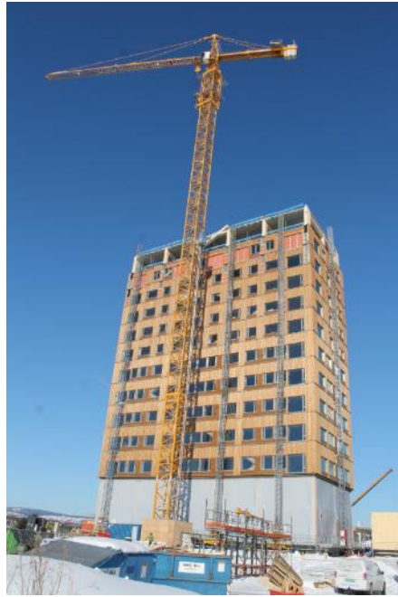
Hevet 28m mellom Trinn 3 og 4
