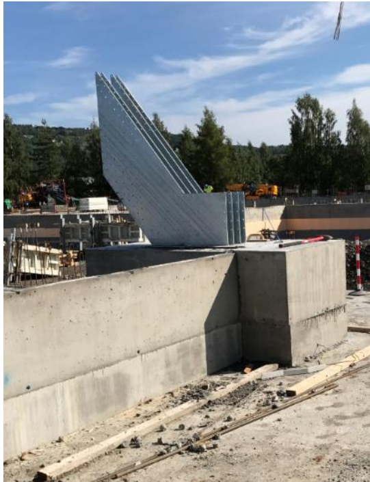
juli 2017 Innstøping av fotbeslag
