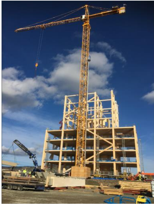
Rigget trinn 1-3 65m høyde
